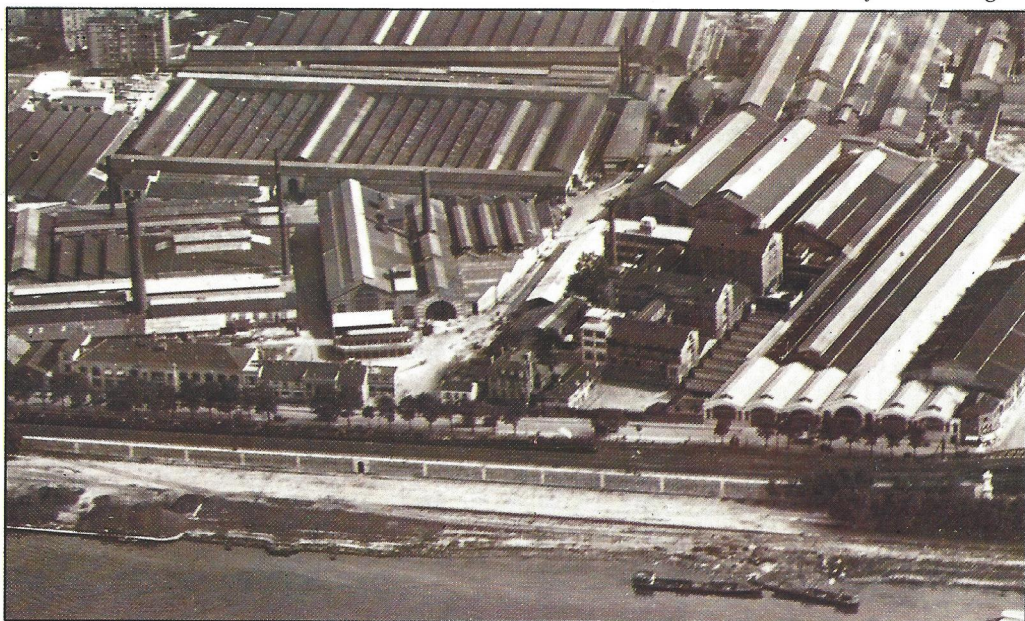
Vue aérienne des premiers bâtiments qui seront entièrement reconstruits en 1933. (Document Citroën 9.870)
